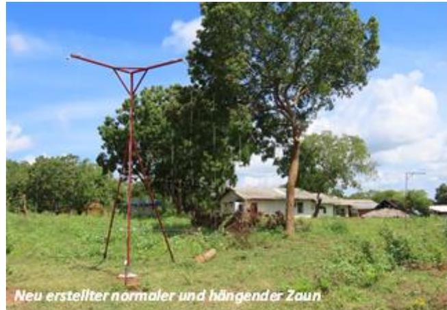
Die Idee: Vertikal aufgehängte und unter Strom stehende lose Drähte schrecken beim Berühren die Elefanten ab und die allenfalls herangetragenen Bäume und Äste finden an den vertikalen Drähten keinen Widerstand und fallen ins Leere.
