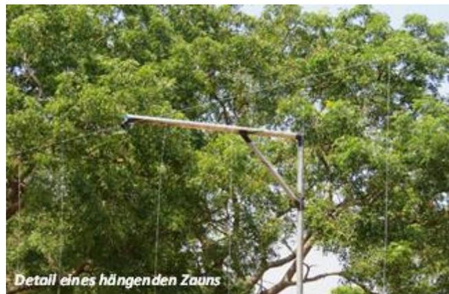
Die Umsetzungspraxis zeigt nun, dass verschiedene Möglichkeiten zum Ziel führen. Da das Material für hängende Zäune fast doppelt so teuer zu stehen kommt, ist es sinnvoll, sie nur gezielt einzusetzen.
